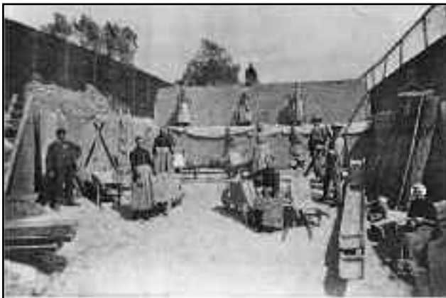
Steenfabriek : volladen van een veldoven voor het bakproces.
