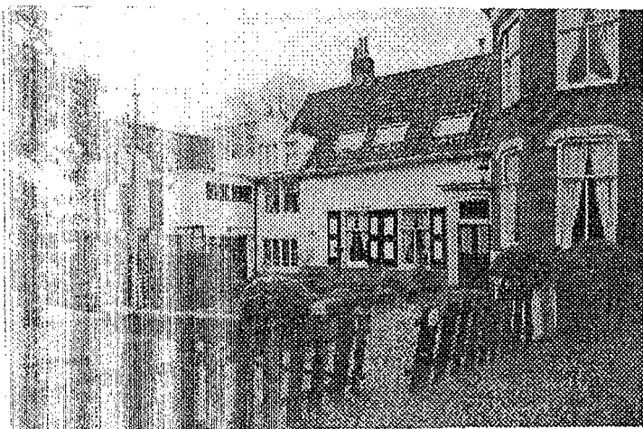
Achter het woonhuis Dorpsstraat 166 is nog een deel zichtbaar van de oorspronkelijke boerderij met levensboom boven de deur, die moest wijken voor de Van Cappellenstichting
